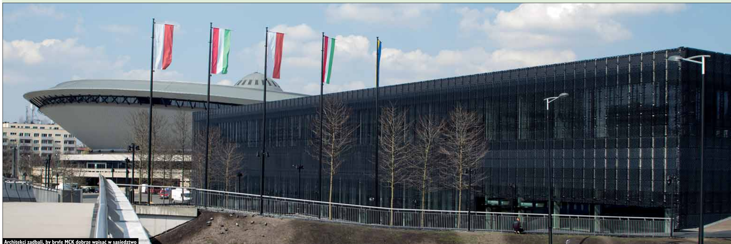
Architekci zadbali, by bryłę MCK dobrze wpisać w sąsiedztwo
