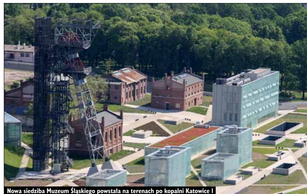
Nowa siedziba Muzeum Śląskiego powstała na terenach po kopalni Katowice I
