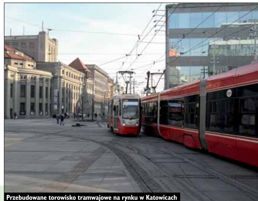
Przebudowane torowisko tramwajowe na rynku w Katowicach
