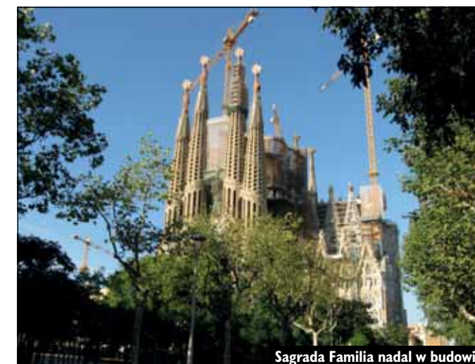
Sagrada Familia nadal w budowie
