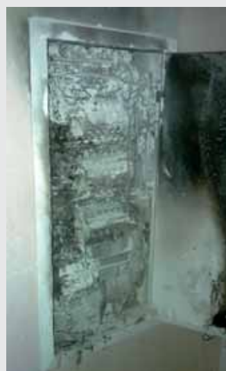
Rys. 9 Uszkodzona rozdzielnica niskiego napięcia z ogranicznikiem „B+C”
