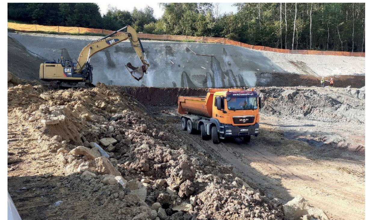
◀ Przygotowanie portalu przed tunelami
