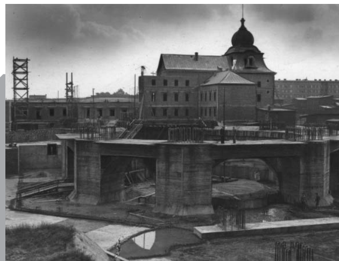
▼ Budowa - stan z 1932 roku
